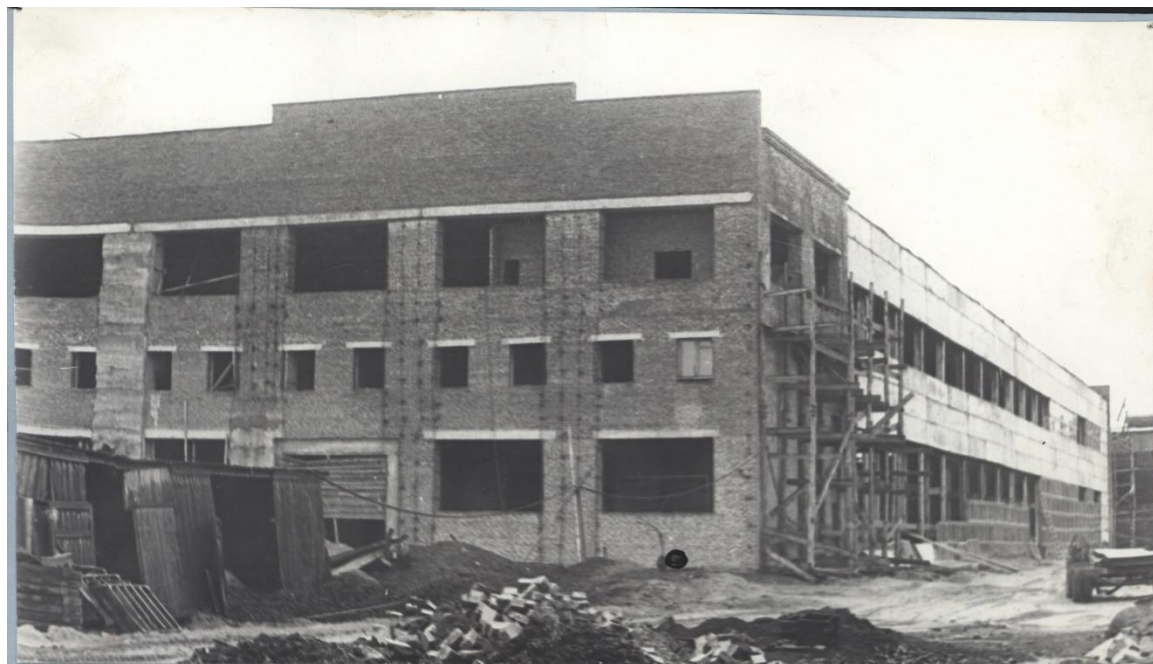
Строительство судостроительного цеха СЗП. Отсюда будут выходить суда полностью готовые к отправке.
